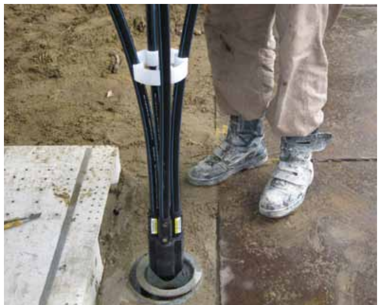
分岐管方式の地中熱交換器
